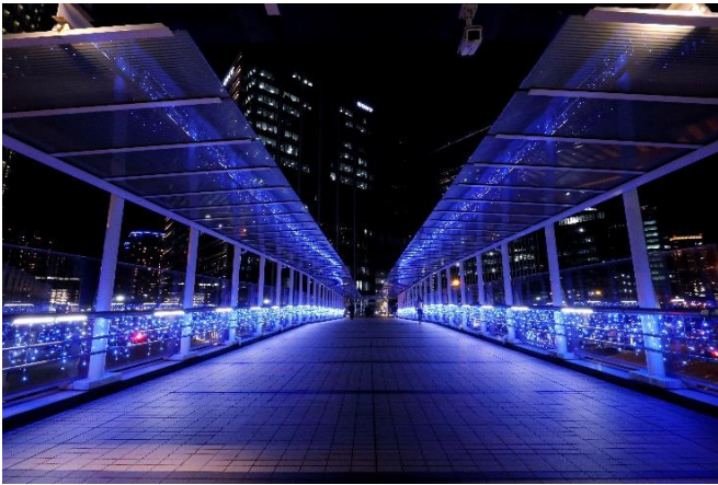
(5) みなとみらい歩道橋
